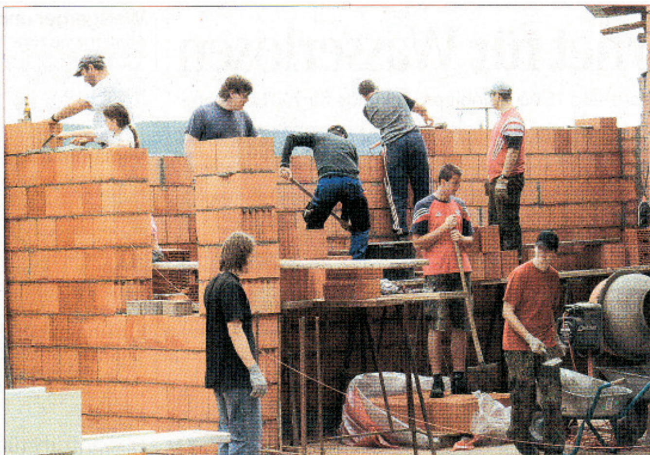
Bei bislang 101 Arbeitseinsätzen leisteten ehrenamtliche Helfer der Freiwilligen Feuerwehr Diebach insgesamt 2045 freiwillige Stunden für den Umbau des Feuerwehrhauses im Stadtteil. In diesem Jahr wird
