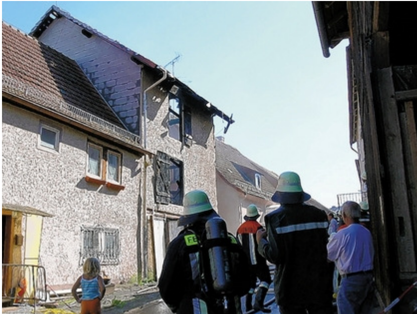
Ausgebrannt ist am Sonntag dieses Nebengebäude in Völkersleier.
